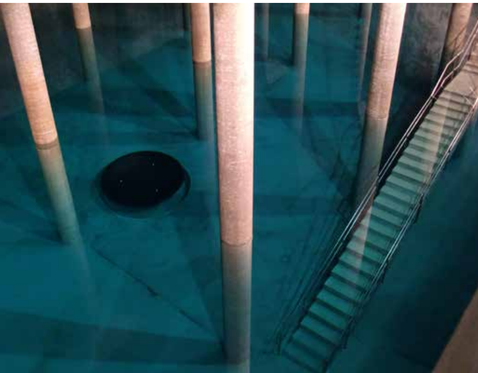
Der Trinkwasserbehälter Hasenbergsteige
